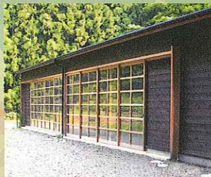
バーベキュー棟
