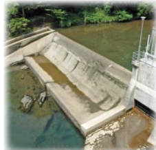
関西電力大見取水堰
