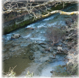
大戸川発電所取水ダム直下
