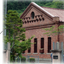
大戸川発電所
