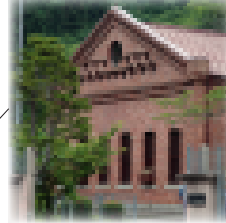
大戸川発電所
